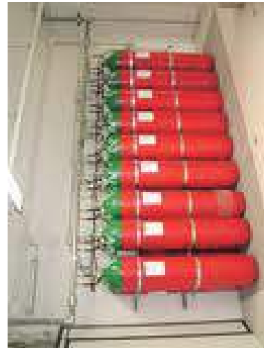
Impianto a gas inerti (es.: argon IG-02)
