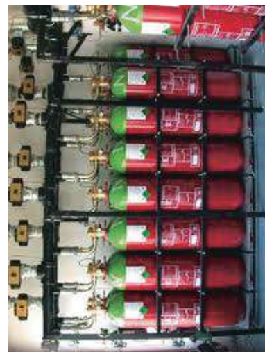
Impianto a gas chimici (es.: HFC-23)
